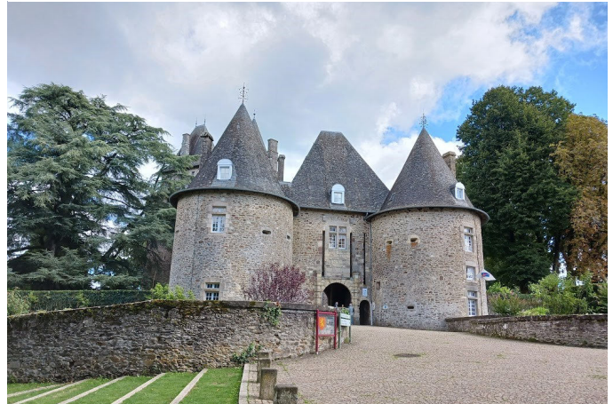
Le château de Pompadour.
